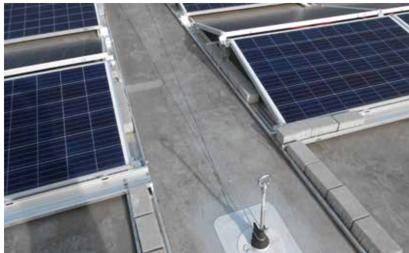
Solche Anbindungen können vor dem Raupeneffekt schützen. Allerdings ist die Frage, wie sie dimensioniert werden müssen. Das Produkt im Bild kann zwar sechs Kilonewton halten, verformt sich aber schon bei 0,5 Kilonewton.
